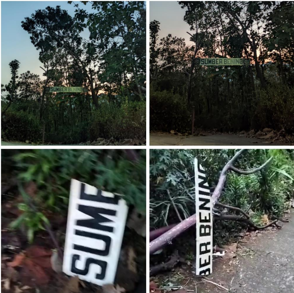
Gambar kondisi gapura sumber bening yang rusak akibat hujan dan angin
